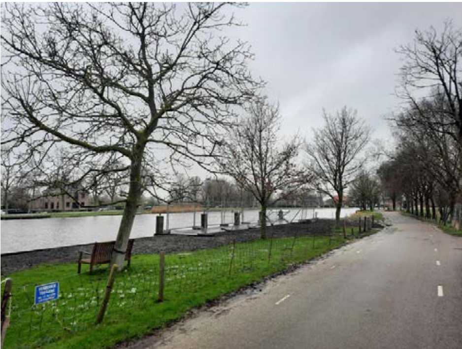
Figuur 9 Grondwerkzaamheden ter hoogte van bomen 288 t/m 290 en 292.
