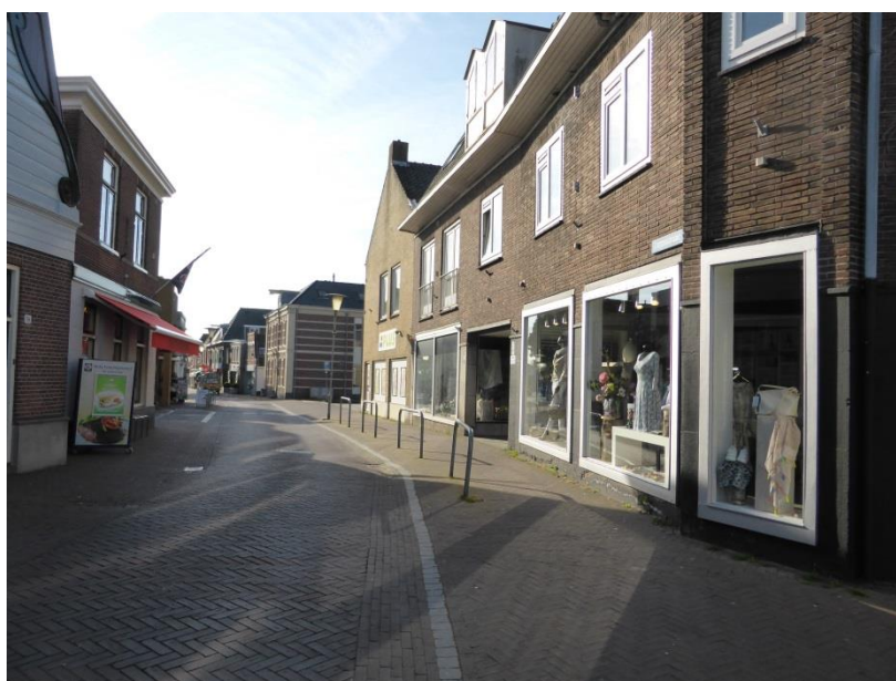
Figuur 3: Referentielijn van de dijk ligt onder het wegdek. Dit leidt tot problemen met aanwonenden bij de ophoging.
