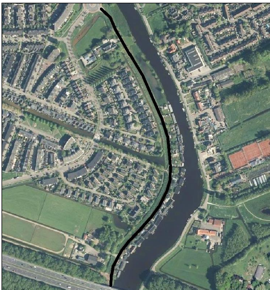
Figuur 1-1 De dijk Rondehoep Oost
