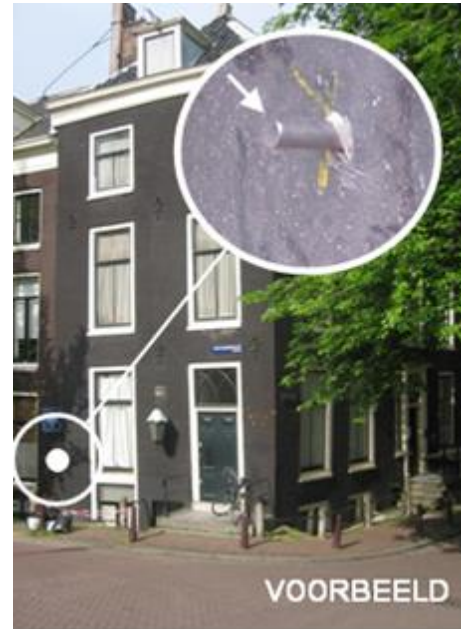
Figuur 4 Voorbeeld hoogtemeetbout
