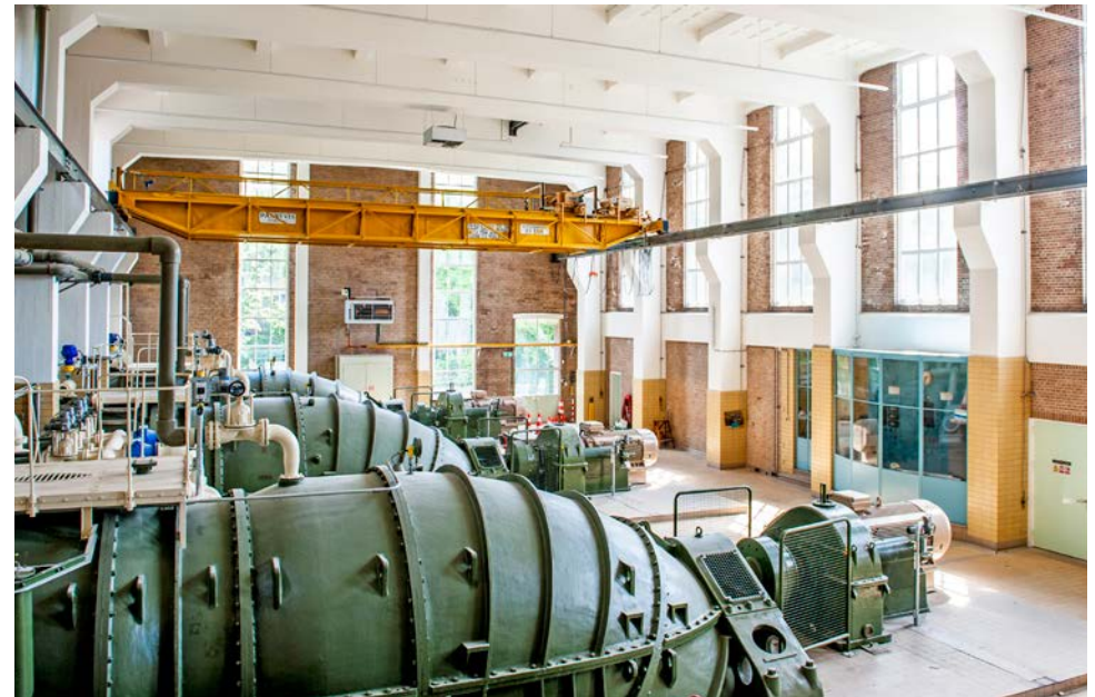
Binnenzijde Gemal Zeeburg
