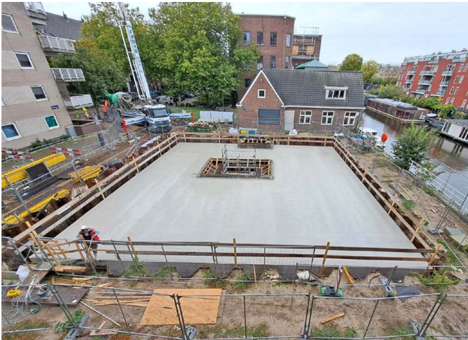
Aanleg warmte/koude-opslag (WKO) bij het Wilhelminagasthuisterrein, Amsterdam.
