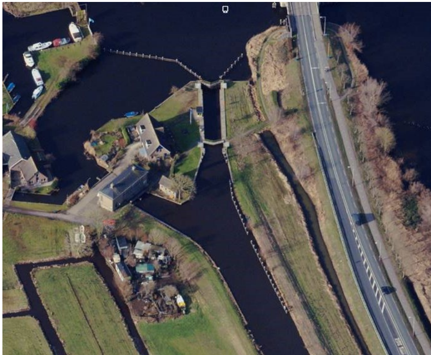
Figuur 2-5 Gemaal De Ruiter (links), Demmerikse Sluis (midden) en de Vinkeveense Plas (rechts). De Geuzensloot is beneden in de foto Bron: Streetsmart, Cyclomedia ©Het variantenafwegingsproces: van Bouwstenen naar het voorkeursalternatief
