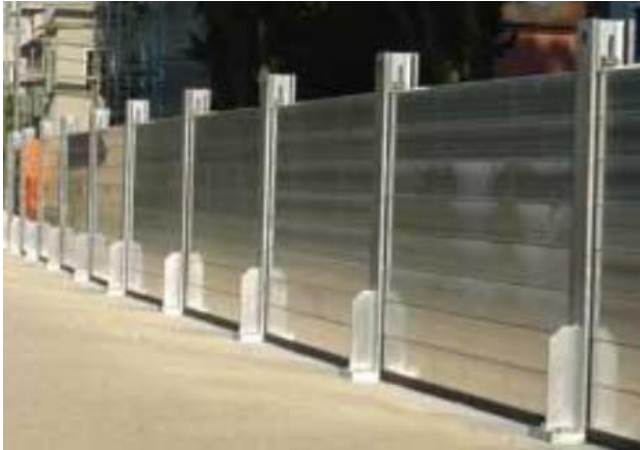
Figuur 9 Demontabele / tijdelijke kering
