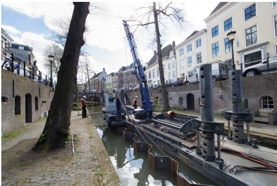
Figuur 26 Drukken van damwanden d.m.v. Silentpiler
