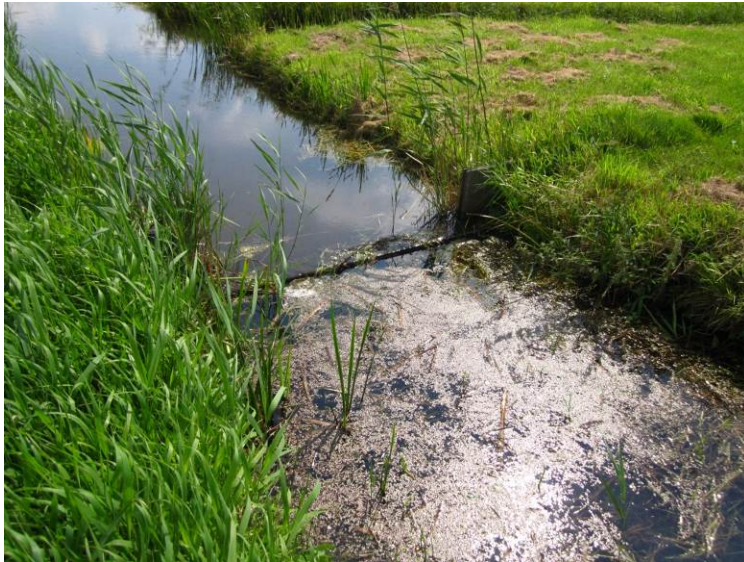
Figuur B4.37 Op de foto is te zien dat het huidige overstortniveau van de stuw die het peil in peilgebied 27-3 bepaalt nagenoeg gelijk is aan het peil in het benedenstrooms gelegen peilgebied 27-1 (NAP -2,3 m).
