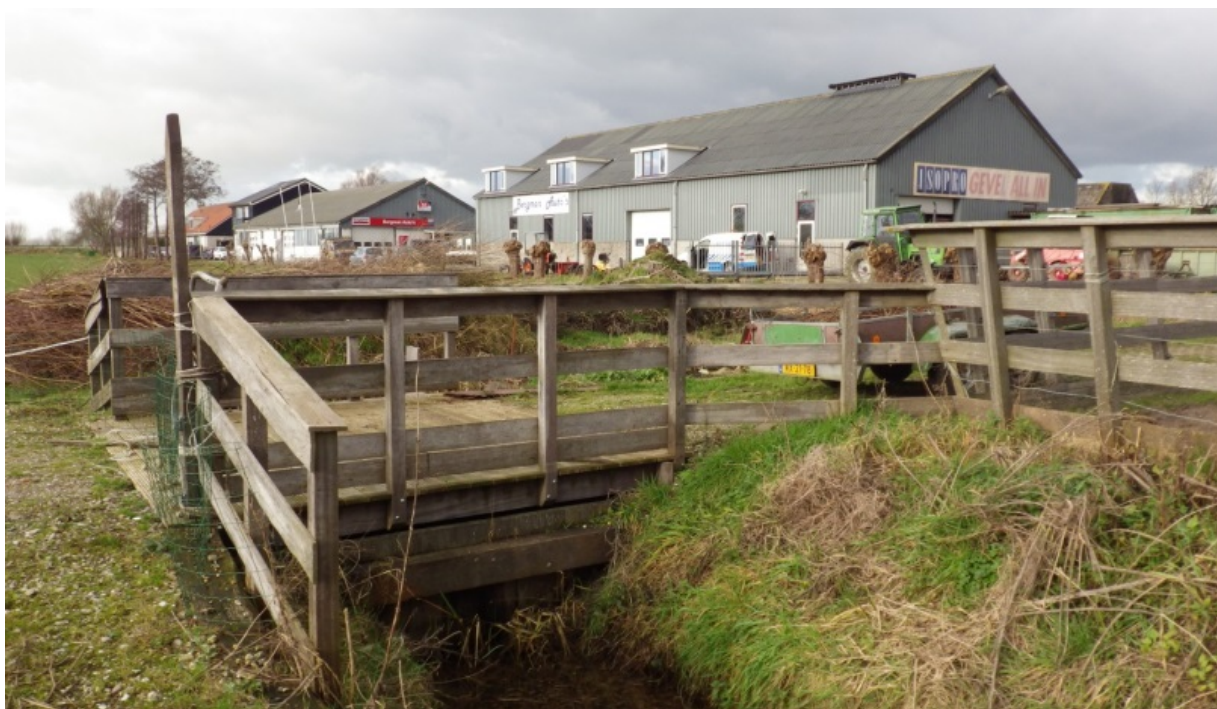
Figuur B4.33 Brug bij de noordelijk stuw van peilgebied 27-5 en toekomstige locatie van de opvoerpomp. De opvoerpomp met afwateringsmogelijkheid moet aan de benedenstroomse (oost)kant van de brug komen.
