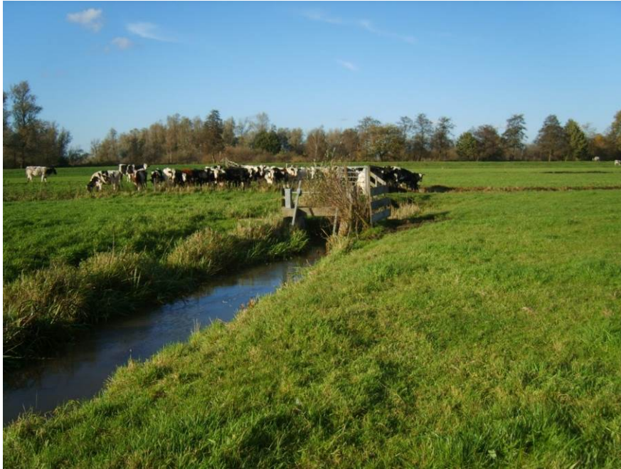
Figuur B4.20 Middelste van de drie stuwen die zijn aangelegd voor het instellen van ANKO-noord en die nog in het gebied aanwezig zijn (locaties maatregel 4A).
