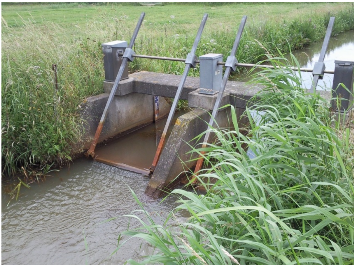
Figuur B4.2 Aanwezige ANKO-stuw (meest westelijke van de drie) die vervangen wordt door een automatische stuw bij de boerderij aan de Radioweg 1. Het vervangen van de stuw is goedkoper dan de huidige stuw automatiseren.
