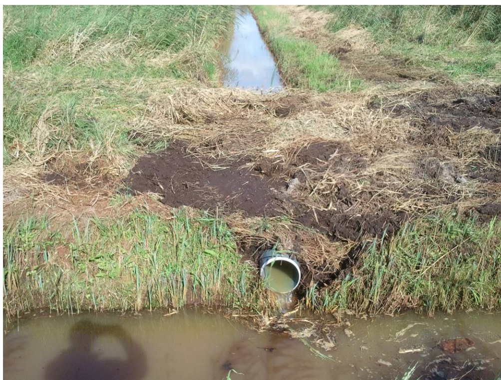
Figuur 6.2 Sloot met een overstortpijpje van peilgebied 28-5 (NERA terrein) naar peilgebied 28-2 (Radiowegsloot).
