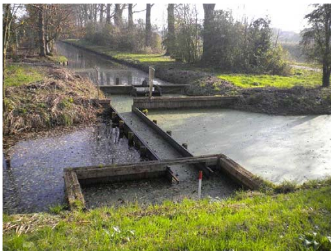
Figuur 5.3 Aquaduct waarmee water uit helofytenfilter en uit de volkstuintuinen gescheiden wordt gehouden
